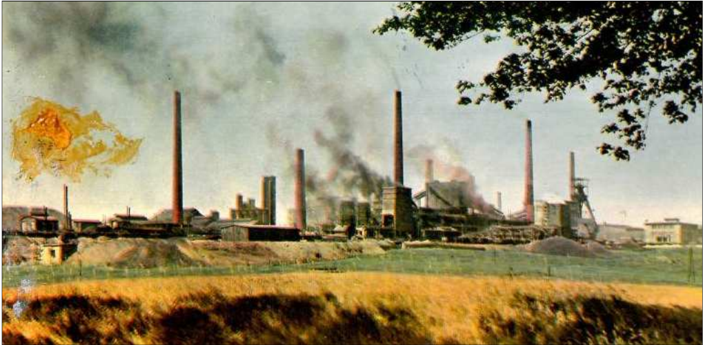
Koksownia od strony ul Rybnickiej
