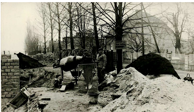
Rok 1981 – rozbudowa budynku straży oraz przylegających do niego segmentów budynku przedszkola i przychodni zdrowia
