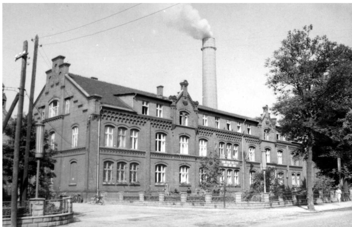
Źródło: zbiory S. Szulik. Budynek kop. „Emma” od strony ul. Korfantego
