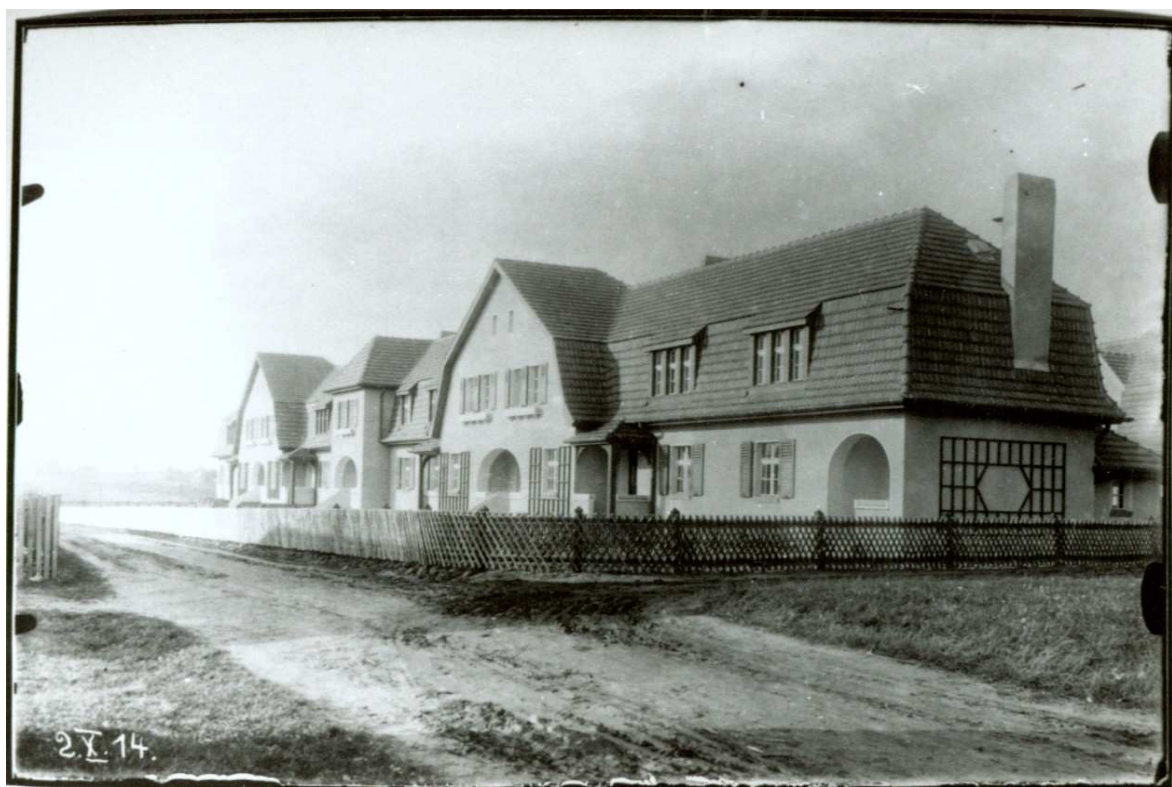
Źródło: Muzeum w Rybniku, Nr inwentarza MR/G-H 126. Budynki robotnicze w nowej kolonii w Biertutowach . 02.10. 1914 r.
