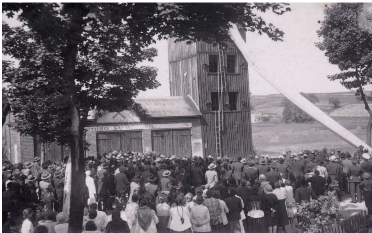
Źródło: zbiory K. Szczotok. Remiza strażacka w Radlinie Dolnym.
